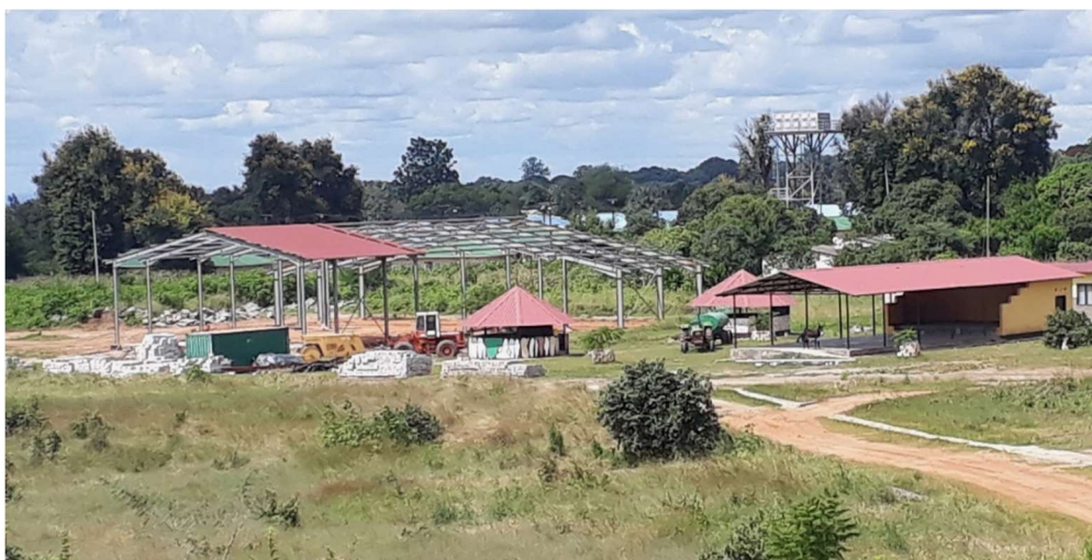
Il cantiere della Chiesa un paio di settimane fa
