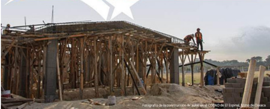
Fotografía de la construcción de aulas en el COBAO de El Espinal, Estado de Oaxaca
